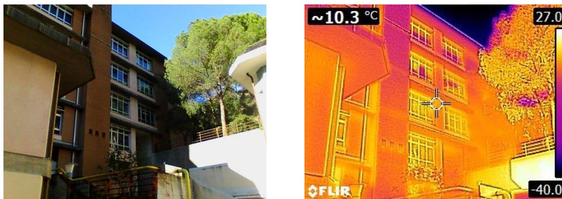
Figura 4.4 – Rilievo termografico della parete
