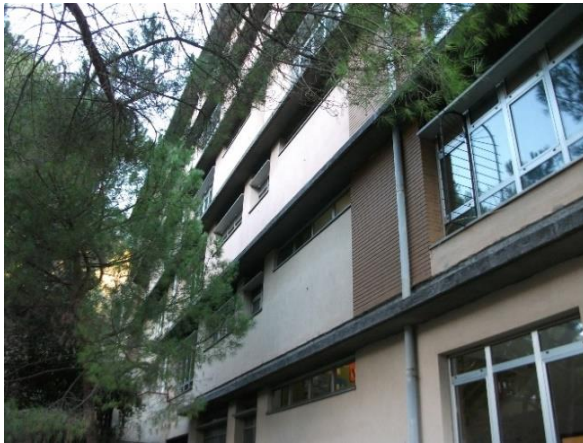
Figura 4.2 - Particolari della facciata
