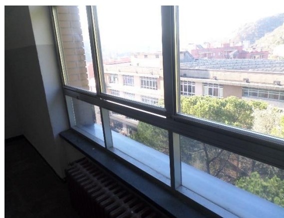
Figura 4.5 - Particolare dei serramenti al terzo piano
