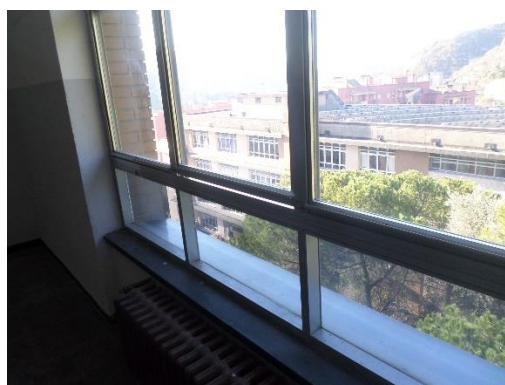
Figura 8.1 – Esempio del vecchio tipo di infissi presenti
