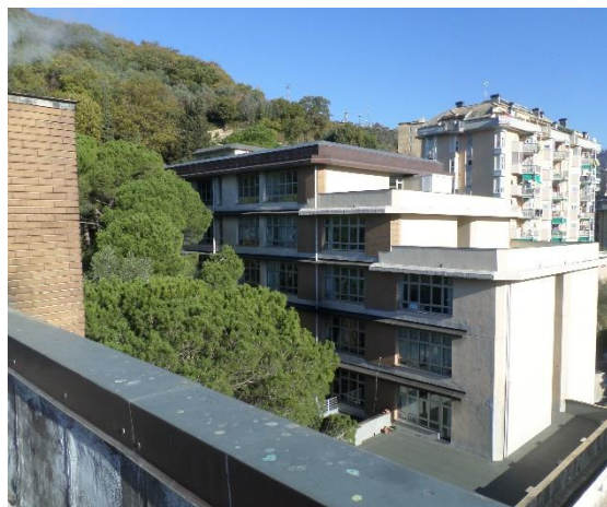
Figura 1.1 - Vista della facciata esposta a Sud-Ovest
